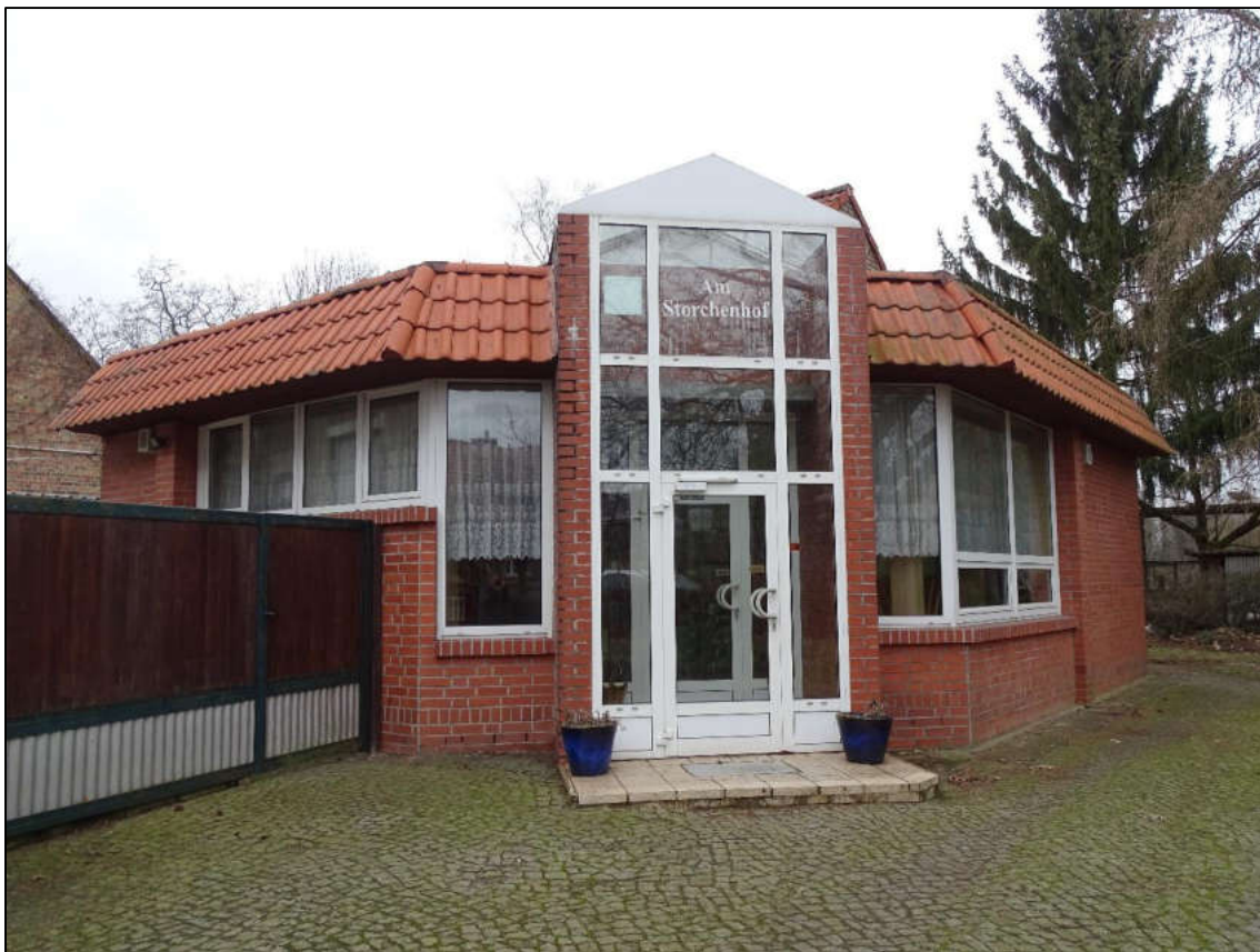
Südost- (oben) bzw. Ostansicht (unten)
